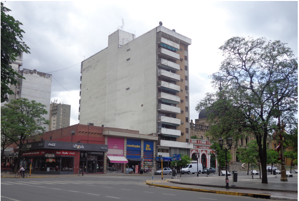
Solar al sur de la Casa de Gobierno. Aspecto actual.
